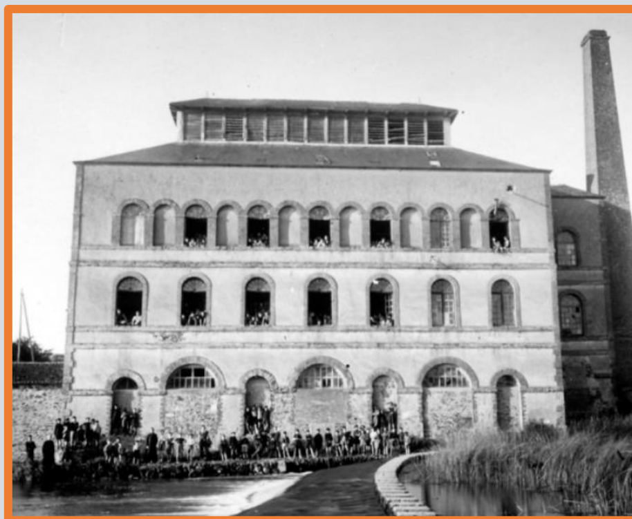
Figure 3. Façade de l'usine d'Angreviers. Fondation des Apprentis d'Auteuil.
